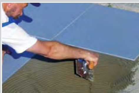
Укладка крупноформатной плитки на клей SUPERFLEX K77
